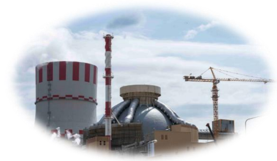
Энергоблок №7 Нововоронежской АЭС
