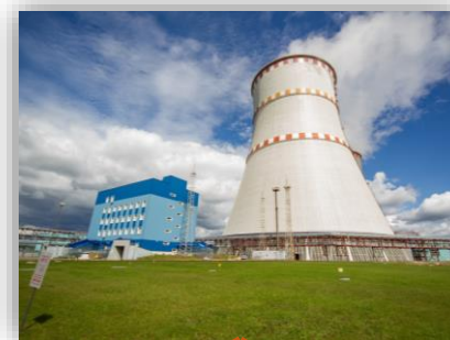
Энергоблок №3 Калининской АЭС
