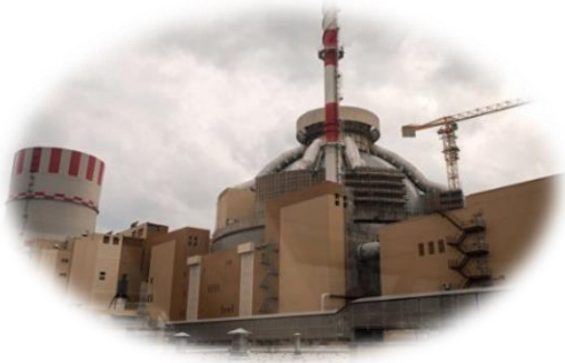
Энергоблок №6 Нововоронежской АЭС
