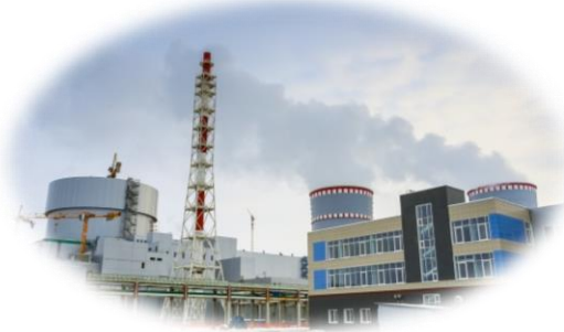
Энергоблок №5 Ленинградской АЭС
