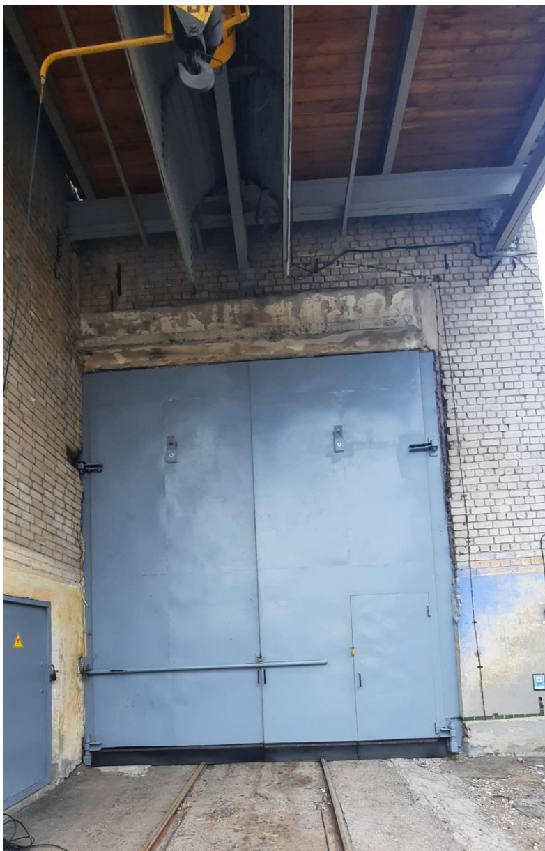
Замена ворот транспортного въезда
