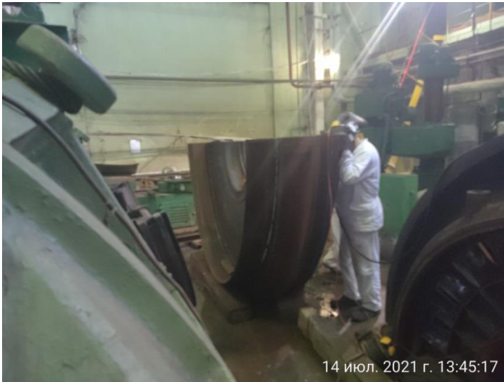
Подготовка к ремонту обойм ЦНД
