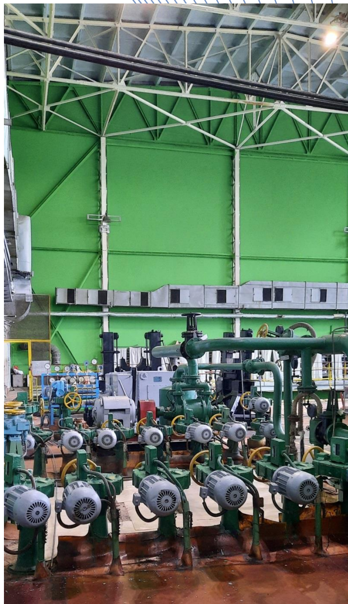
Огнезащитная обработка ферм машинного зала, косметический ремонт стен и крыши
