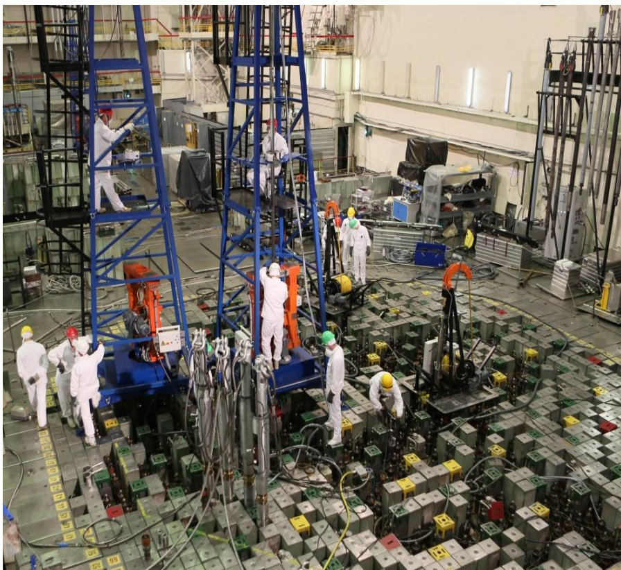
Ремонт графитовой кладки: устройства для одновременного распила нескольких графитовых колонн
